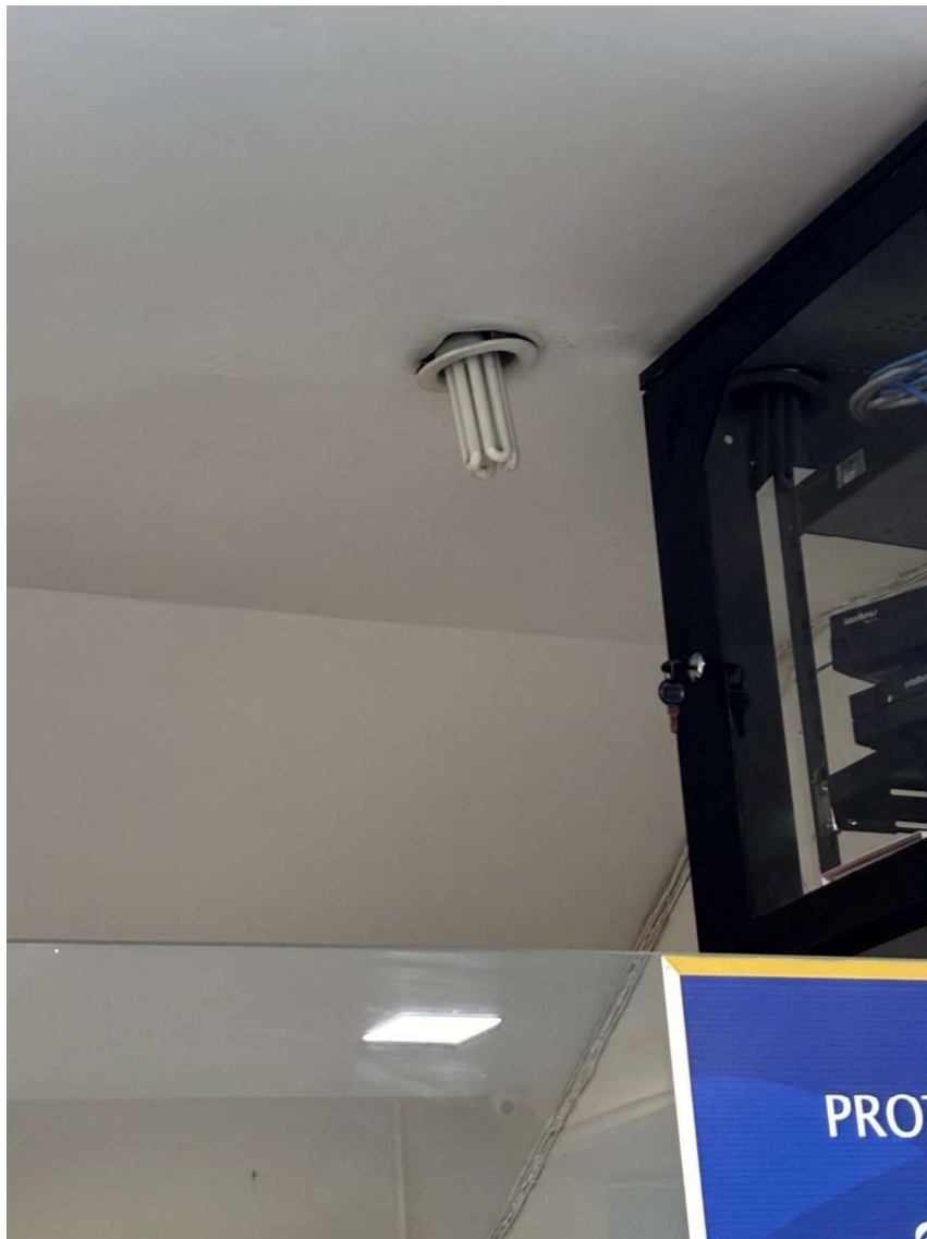
Substituição de luminárias defeituosas por modelos adequados.
